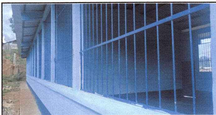
Foto 5: Todos las ventanas de madera se remozaron con valcones de metas para una buena ventilacion en cada una de las aulas.
