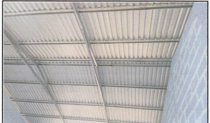
Foto 2: Se le dio remozamiento correctivo al techo con estructura metalica para que los niños tengan un techo adecuado para recibir la enseñanza parendizaje.
