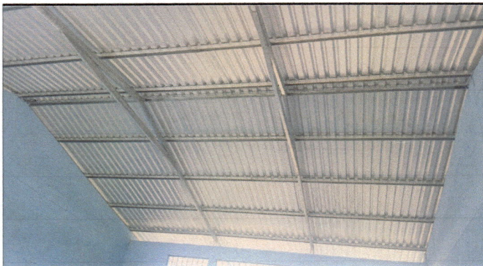
Foto 3: Se sustituyo las laminas a calibre 26 como tambien la estructura metalica a cada una de las aulas de la escuela.
