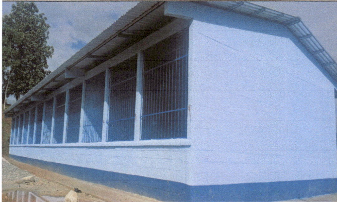
Foto1: Se le dio remozamiento correctivo a los valcones de las ventanas como tambien la estructura metalica del techo con el apoyo del Programa de Edificios Escolares Publicos.
