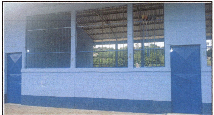
Foto 4: De esta manera quedaron las mejoras que se le dio a las cuatro aulas, puertas de metal ventanas de valcones con el apoyo del Programa de Mantenimiento a Edificios Escolares Publicos.
